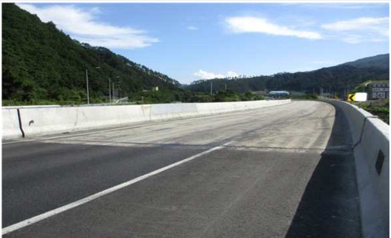
교량 상부 전경
